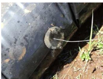
Válvulas de entrada
